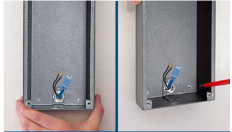
Gehäuse anbringen und die Türstation anschließen
